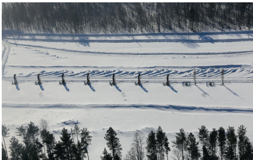
Куст скважин малого диаметра, оборудованный цепными приводами и гидроприводами. НГДУ «Елховнефть»
